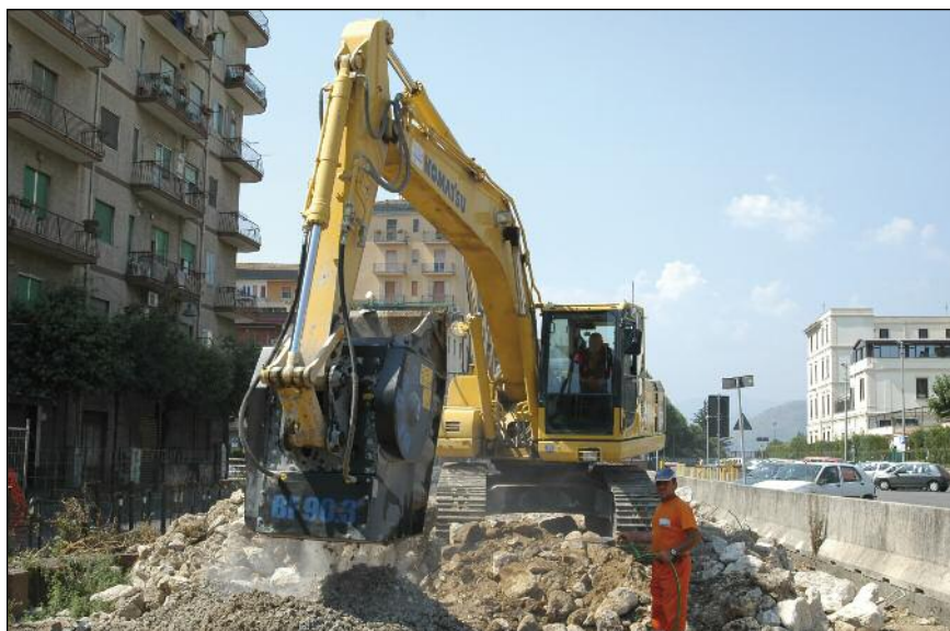
■ La struttura del cantiere si allunga per diversi chilometri ma ha una larghezza inferiore ai 50 m
