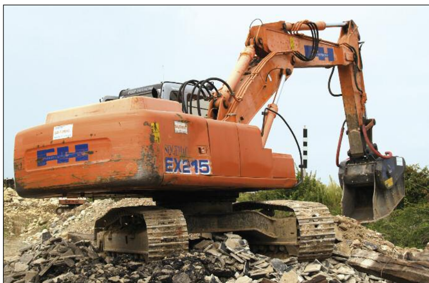
■ Scarlatta, nata nel 1926, è una delle aziende storiche del biellese. La sua attività spazia dai restauri dei beni architettonici e monumentali al consolidamento dei terreni, dalle opere civili allo stradali, dalle infrastrutture alle demolizioni e ai ripristini fluviali
