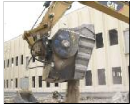
■ La BF 90.3, montata su un escavatore cingolato 324D Caterpillar da 28 t, imbenna con rapidità notevoli quantitativi di materiale e, con sorprendente rapidità, macina il vecchio massetto con facilità irrisoria
