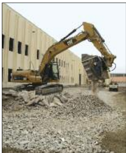
■ Fondamentale l'apporto della benna frantoio: il materiale demolito viene frantumato, recuperato e utilizzato per la regolarizzazione del fondo di costruzione del nuovo massetto
