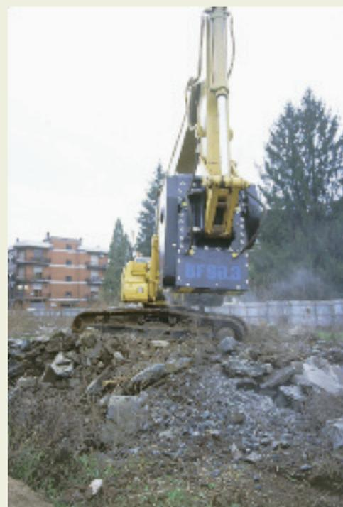
L'escavatore sale sul cumulo di basalto, la tipologia di roccia più dura emersa durante gli scavi per le posa delle fondamenta.
