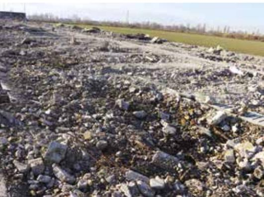
**↑** PARTICOLARE DEL MATERIALE RISULTANTE DALLA DEMOLIZIONE DELLE PORCILAIE, UN MISTO DI CEMENTO ARMATO E GRIGLIATI PER STALLE
