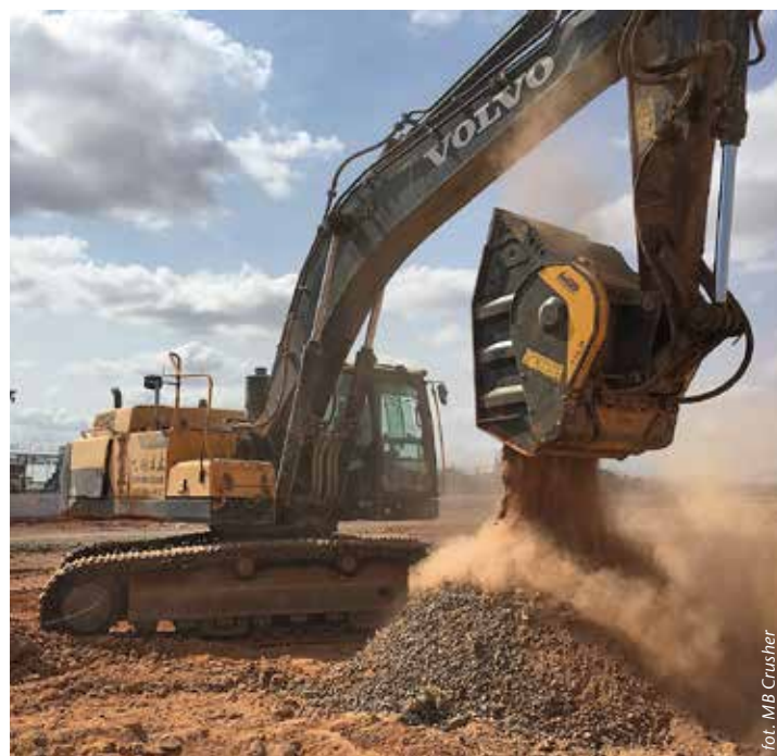
Na budowie Międzynarodowej Strefie Wolnego Handlu w Dżibuti bardzo dobrze sprawdza się łyżka krusząca BF120.4 firmy MB Crusher.
