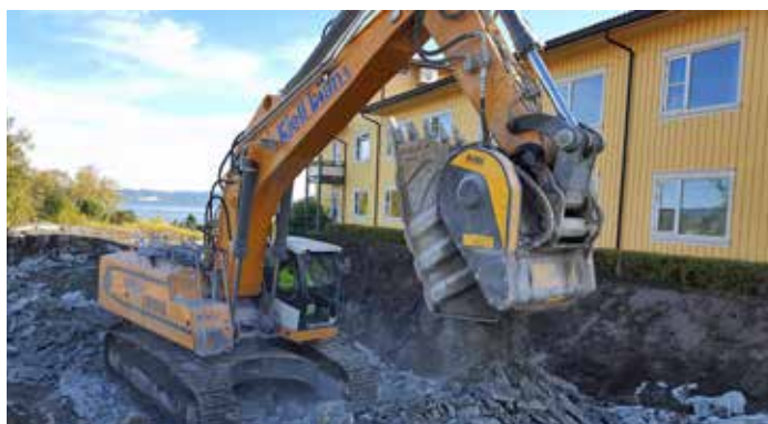
På dette anlegget sprengte de ut 6000 faste kubikkmeter, 4000 av de ble knust med knuseskuffe på stedet til ombruk.
