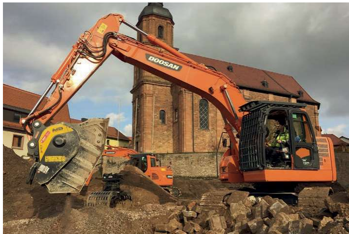
La benne frantoio durante la ricostruzione di una storica piazza in Baviera
