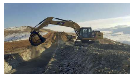
Le benne vaglianti durante i lavori per la realizzazione del gasdotto del South Caucasus
