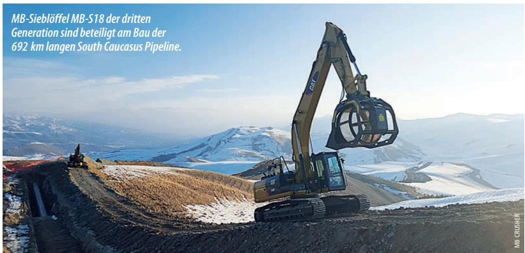
MB-Sieblöffel MB-S18 der dritten Generation sind beteiligt am Bau der 692 km langen South Caucasus Pipeline.
