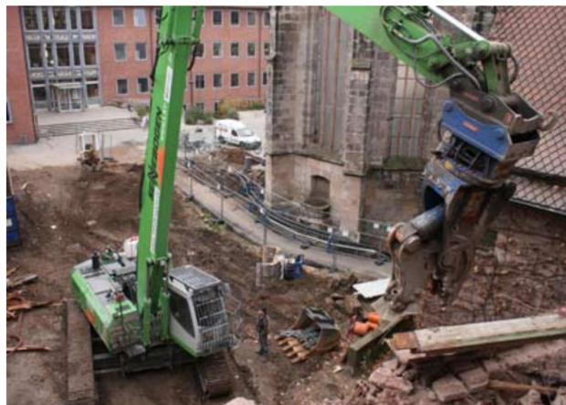
Die Multifunktionsmaschine 830 R-HDD von Sennebogen verfügt über ein zweigeteiltes Auslegersystem mit einer Reichhöhe von 20 Metern und hat eine serienmäßig installierte hochfahrbare und neigbare Kabine für beste Übersicht und sicheres Arbeiten.
