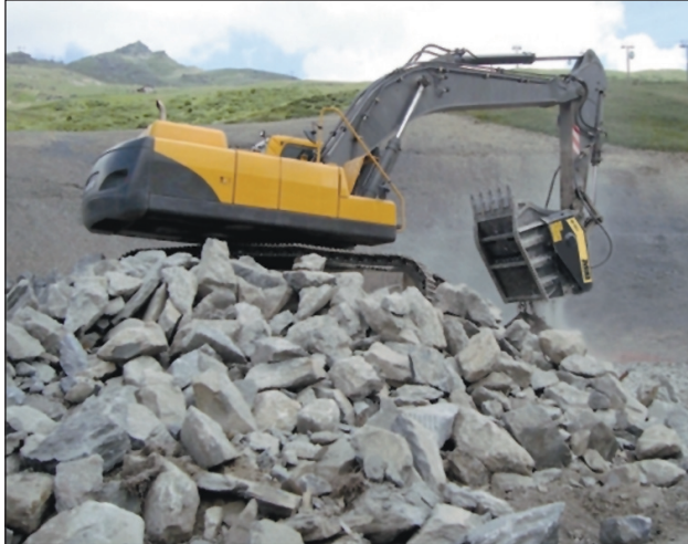
Figura 1.- Las cucharas MB entran a formar parte sustancial en la construcción del metro de Tokio.
