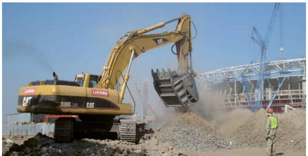
Mit einem Backenbrecherlöffel BF 120.4 wird Abbruchmaterial, das beim Stadionumbau für die Fußball-WM 2010 anfällt, direkt vor Ort zerkleinert und wiederverwendet.
