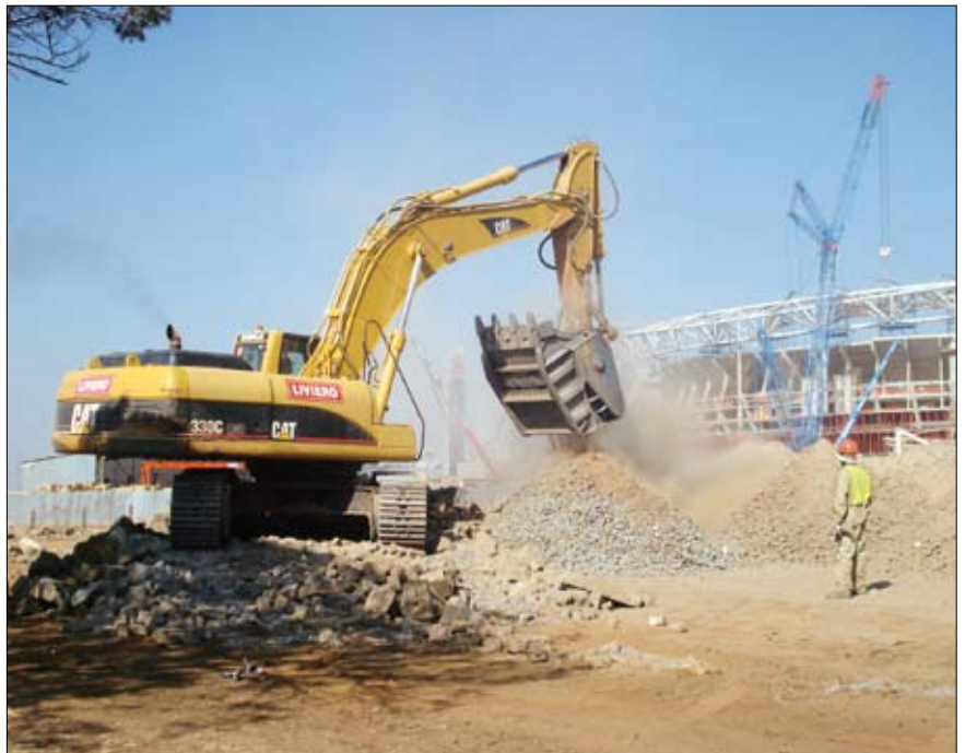
MB-Backenbrecherlöffel beim Bau des neuen WM-Stadions in Johannesburg.
