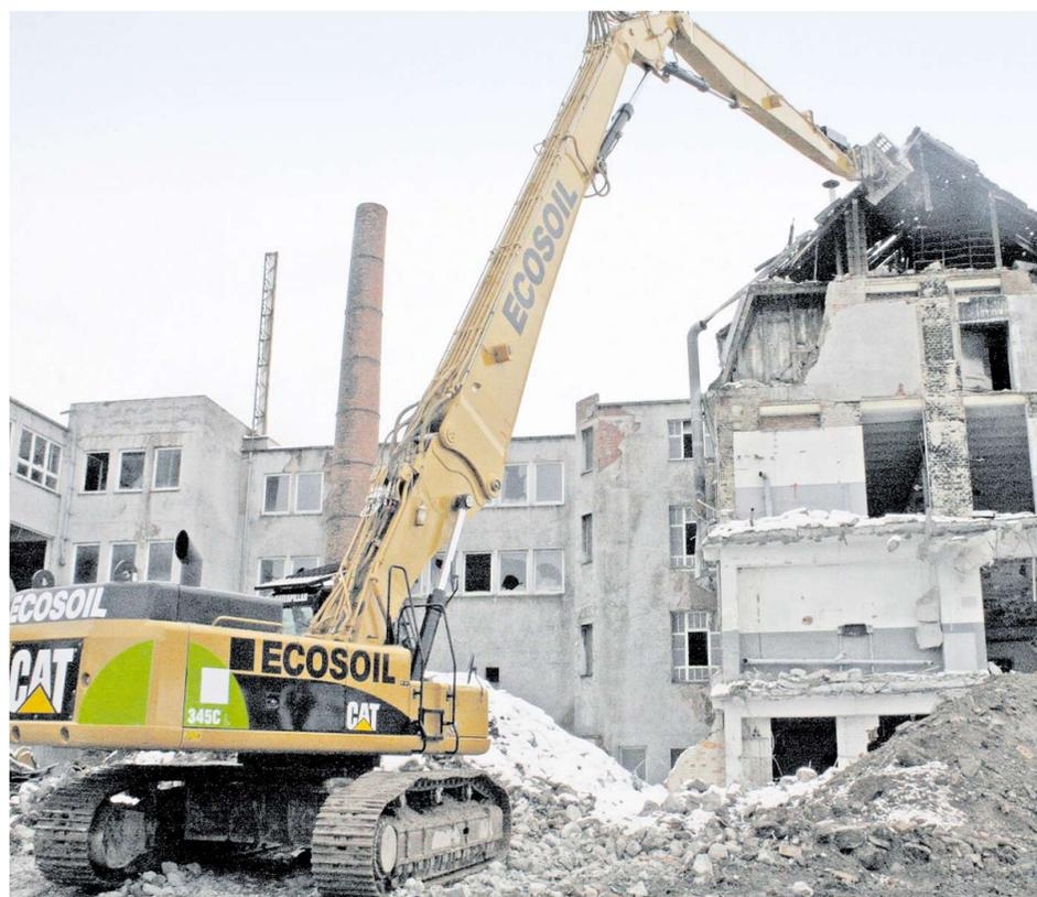
Mit seinem 28 Meter langen Ausleger erreichte der Cat Longfrontbagger die Firsthöhe von 22 Metern.
