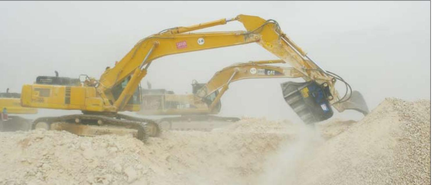
Die bewährten Backenbrecherlöffel von MB sind auch beim Bau der 600 km langen Autobahnstrecke zwischen Hyderabad und Bangalore in Indien im Einsatz. (Foto: MB)
