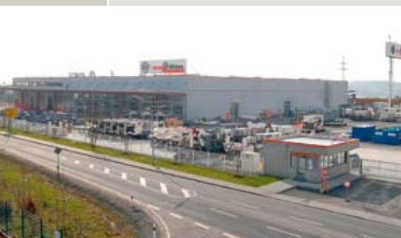
Das neue Wirtgen-Werk für Sondermaschinen in Windhagen
