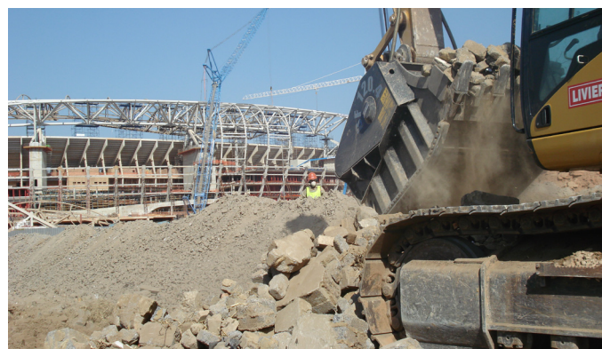
En av MB:s skopkrossar i fullt arbete på Soccer City Stadium.
