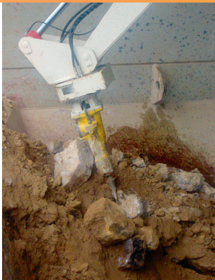
Leiblein Mining hat eine große Brecheranlage mit dem Sekundär-Zerkleinerer ausgerüstet.
