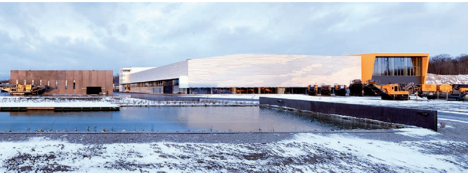
La nueva planta de producción de Hartl Anlagenbau GmbH en St. Valentin (Austria)
