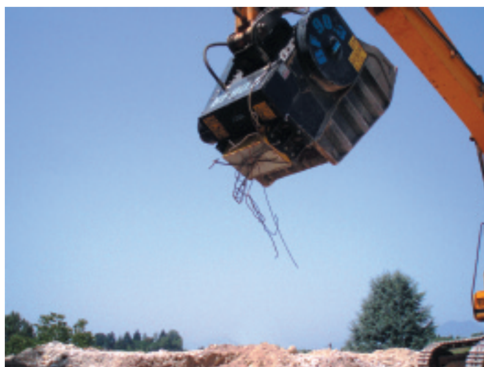
Le séparateur magnétique, ou électro-aimant, permet de séparer les matériaux ferreux des autres matériaux concassés.
