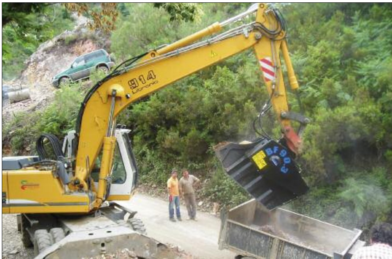
■ Molteplici le aree di applicazione che comprendono: demolizioni, edilizia in generale, movimento terra, scavi, lavori stradali, cave, miniere, bonifiche ambientali e scasso vigneti
