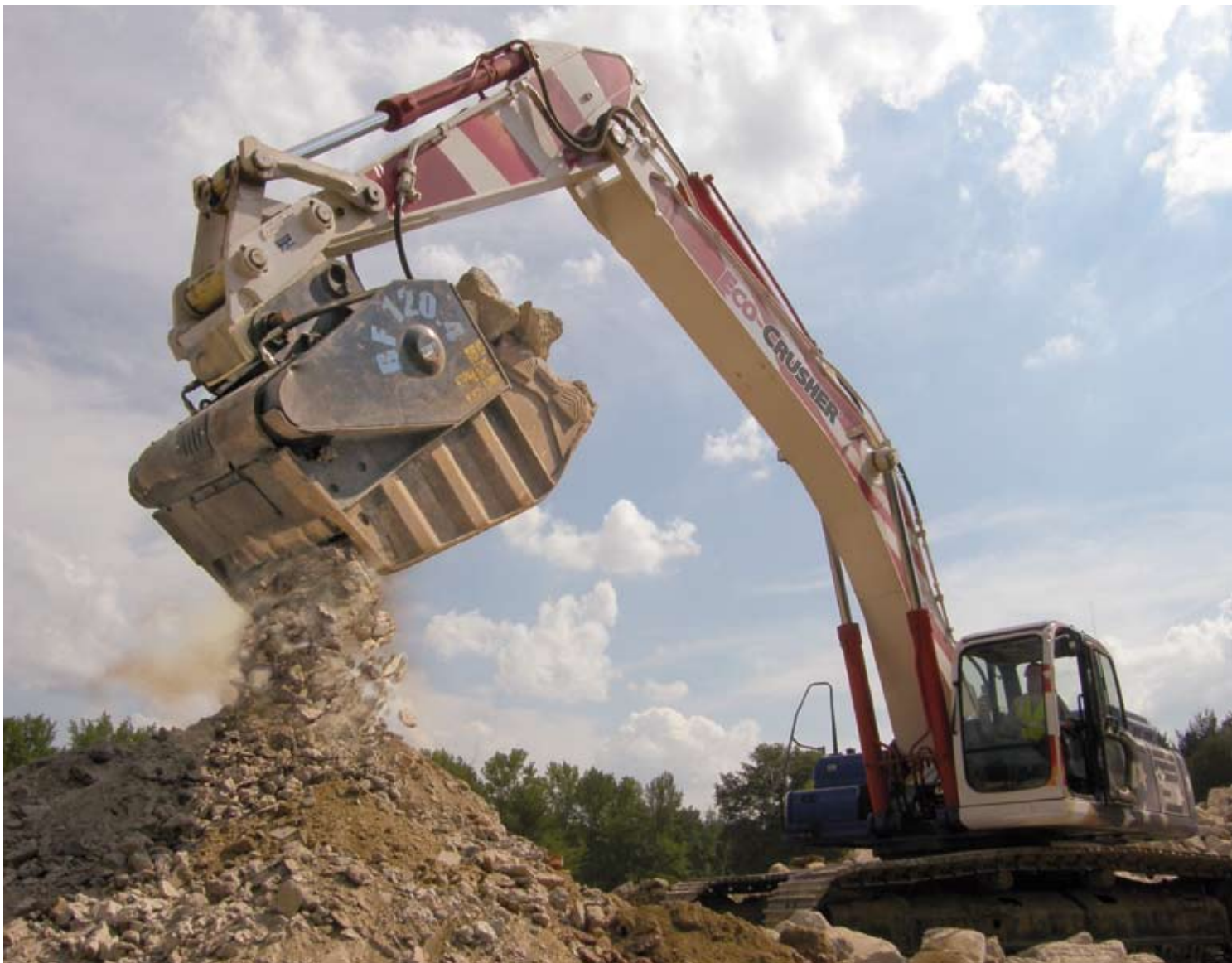
Der MB Crusher im Abbrucheinsatz
