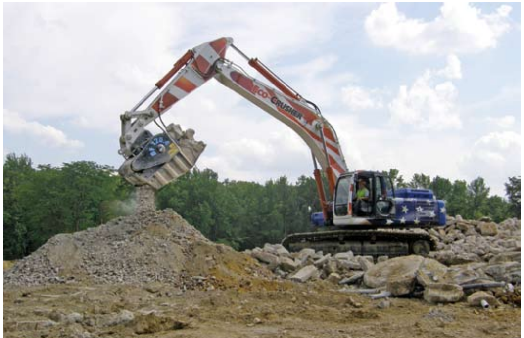
■ Projekt je izgradnja 1635 kuća i obnavljanje još njih 443 za potrebe vojnih obitelji
