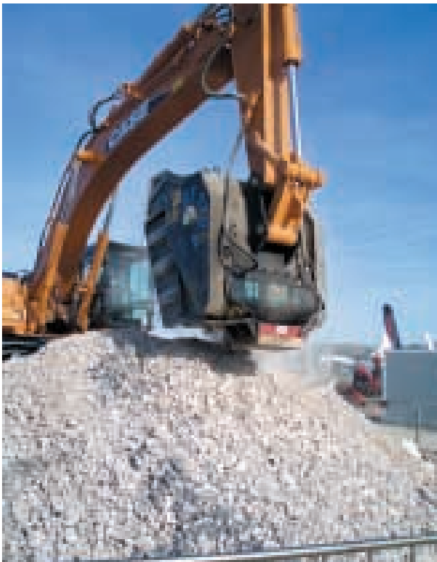
Figura 2.- Meccanica Breganzese contó con una zona de demostraciones en Smopyc 2008.
