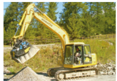
Riduzione delle macerie in materiale inerte di piccola pezzatura
