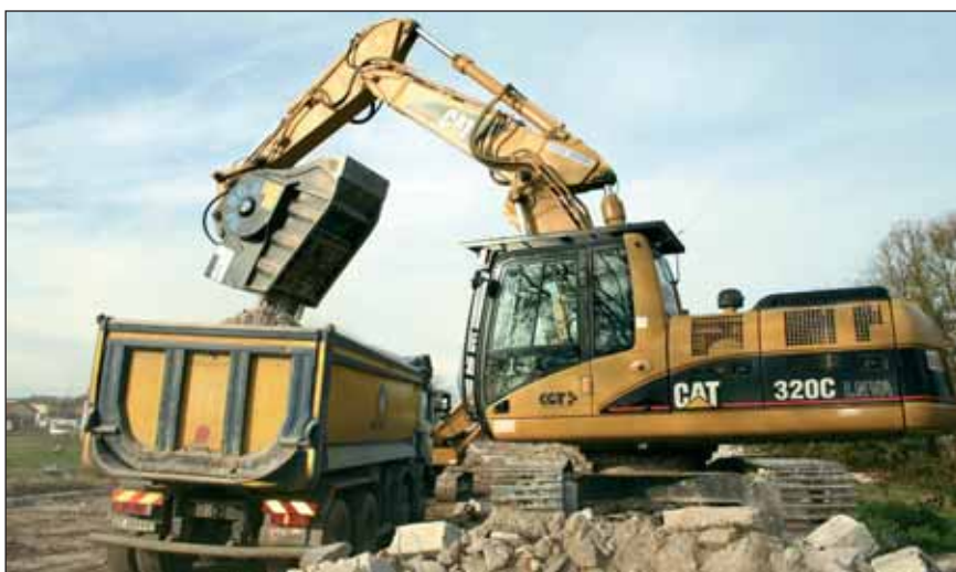
■ Buona la produttività dell'attrezzatura, che in questo cantiere raggiunge i 20 m 3 /h di materiale frantumato Attachment productivity is high: on this particular site it reached 20 m 3 of crushed material per hour
