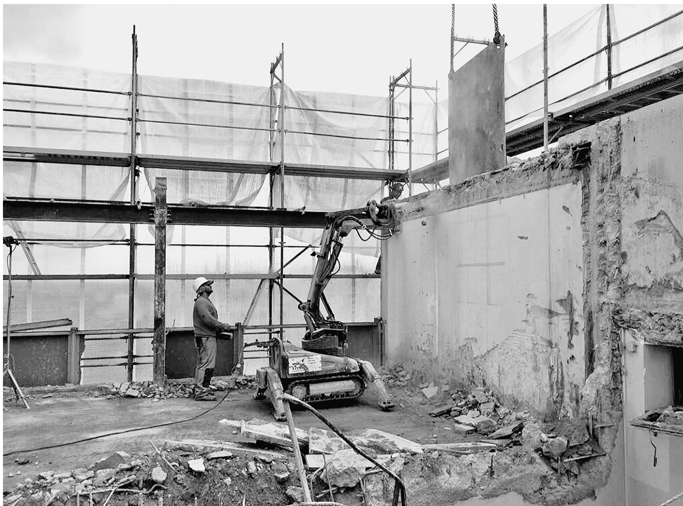
Auch ferngesteuerte Abbruchroboter kamen zum Einsatz.
