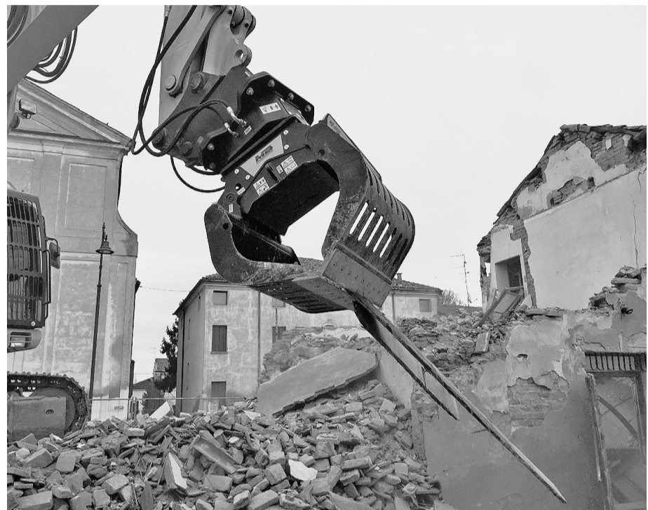
Ein praktisches Beispiel für die Effizienz in Sachen Sicherheit ist eine Baustelle in einer italienischen Kleinstadt, auf der ein Abbruchunternehmen einen Sortiergreifer von MB, den Crusher MB-G900 eingesetzt hat, um ein dreistöckiges Gebäude in einem Wohngebiet abzureißen.
