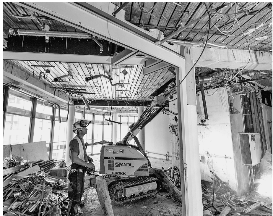
Mit dem Darda Multi Cutter MC200 separiertes Material kann jetzt einfach entsorgt werden.
