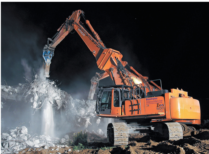
Nachts sind keineswegs alle Bagger grau, wie ein Hitachi ZX500 mit vielseitigem Wechsel-Auslegersystem beweist und in kurzer Zeit eine Brucke zerknabbert
