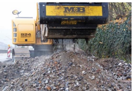
Eine Erfahrung, die nicht nur die Firma Schleis machte: Schon mit wenigen 100 m<sup>3</sup> Bauschutt pro Jahr lohnt sich die Investition in einen MB Brecherlöffel. Im Bild der MB Brecherlöffel im Einsatz auf der beengten Baustelle.
