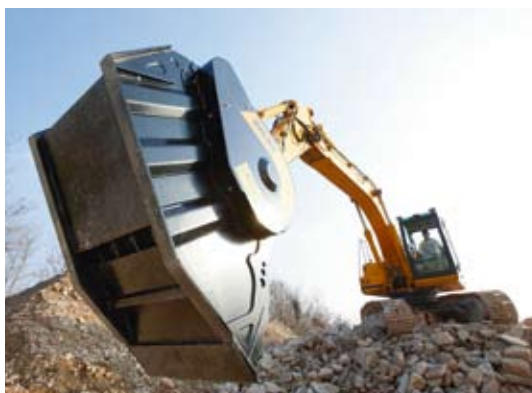
MB Backenbrecherlöffel beim U-Bahn-Bau in Japan
