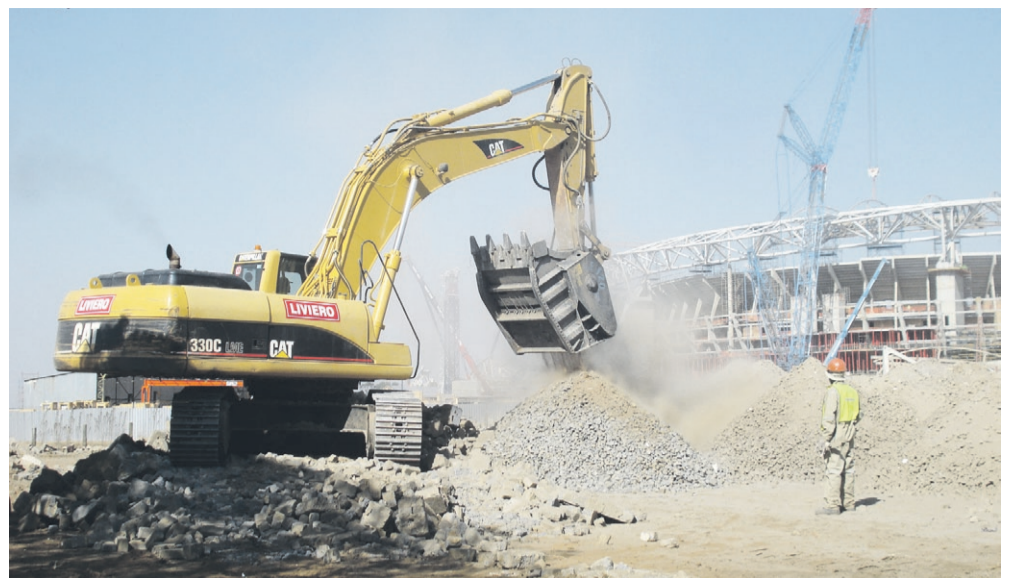
En store gravemaskine med knuseskovl i gang med at knuse brokker ved byggeriet af det nye stadion i Johannesburg, hvor VM-finalen i fodbold skal spilles.
