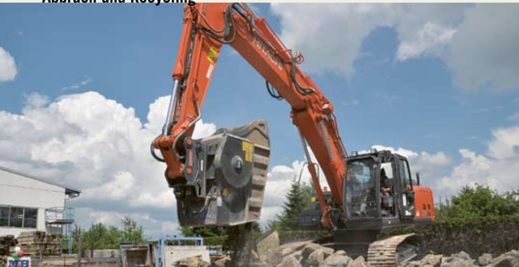
Mittelschwere Abbruchbagger wie dieser 25-Tonner von Hitachi sind ideale Grundgeräte für Brecherlöffel von MB. Per Schnellwechsler aufgenommen und an die Bordhydraulik angeschlossen, brechen sie Naturstein und Beton zum sofortigen Wiedereinbau herunter.
