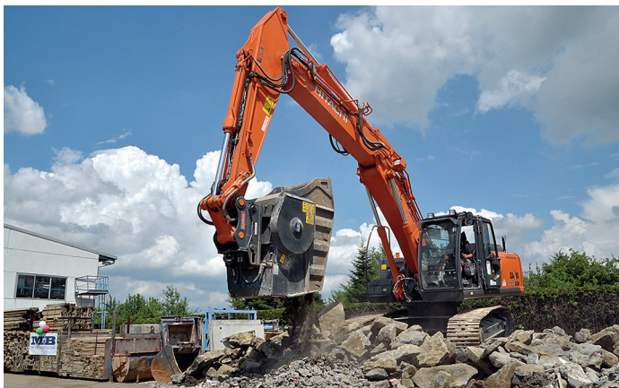
An Hydraulikbaggern montiert, zerkleinern Brecherlöffel von MB mineralische Restmassen für den Wiedereinbau
