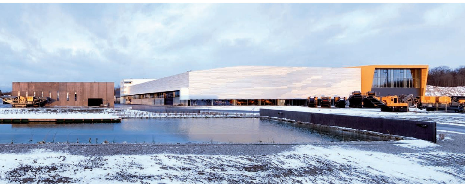
Das neue Produktionswerk der Hartl Anlagenbau GmbH in St. Valentin, Österreich
