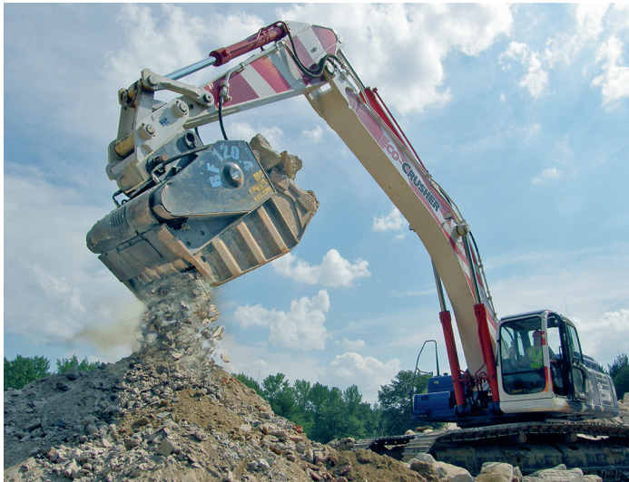
Auf den Baustellen des amerikanischen Militärs kann man überall den Backenbrecherlöffel BF von MB finden Bild: MB
